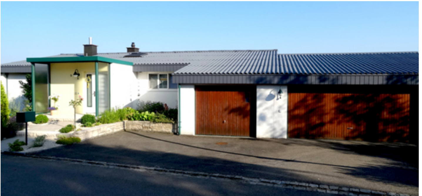
Vorderansicht mit Eingangsbereich
